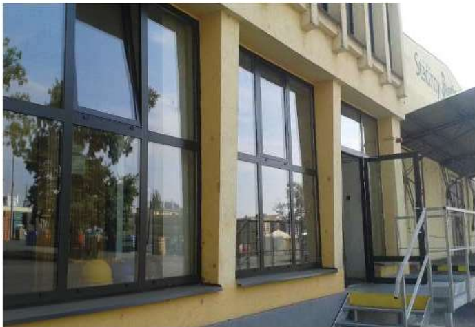
Plzeňský Prazdroj: - prosklené hliníkové výlohy RAL 8019 - opláštění sanitace a plnění cisteren, sendvičové minerální panely
