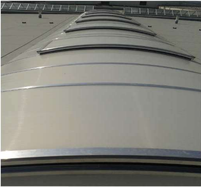
Christ Car Wash, hala 17 – střešní TR plechy a světlíky
