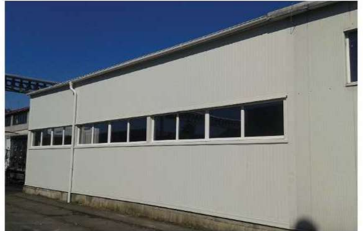
Plzeňský Prazdroj: - prosklené hliníkové výlohy RAL 8019 - opláštění sanitace a plnění cisteren, sendvičové minerální panely
