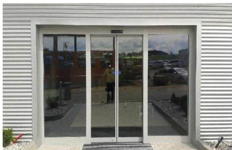
Vstupní portály: - autoservis - Autosalon Škoda - Femat Praha
