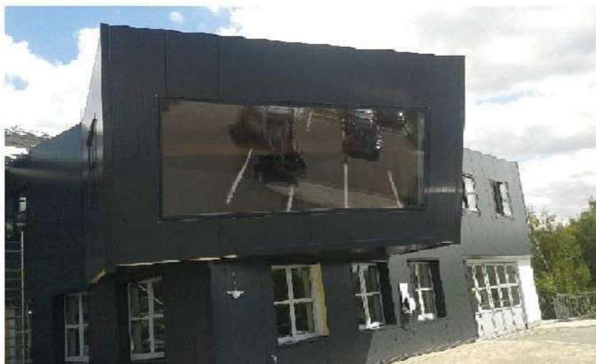
Nadrozměrné okno, CAR POINT Karlovy Vary, rozměr 6x2,3m, váha 1000kg, odklon 20stupňů
