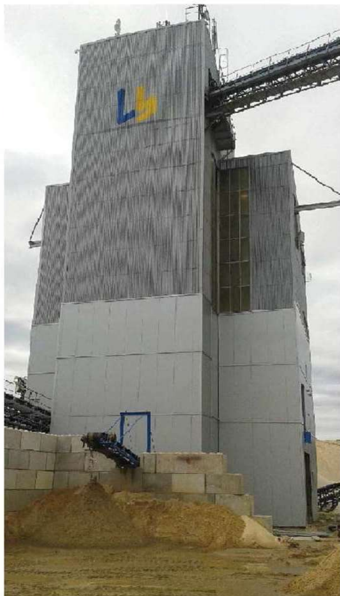
Rekonstrukce opláštění třídění živců Halámky, LB Minerals
