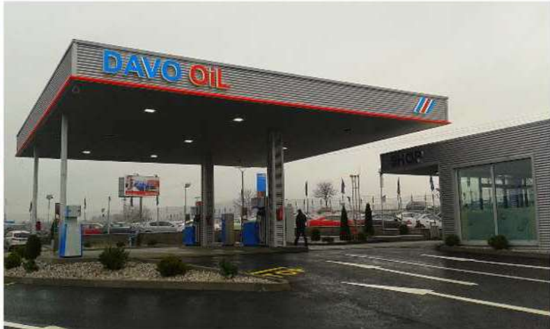
Zastřešení čerpací stanice pohoných hmot DAVO CAR Olbramovice - ocelová konstrukce 13000kg, včetně opláštění.
