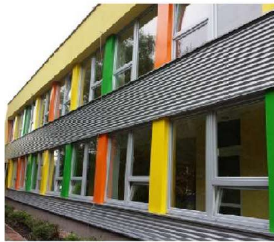
MŠ Přetlucká - barevná ocel. fasáda a nosná spodní kce.
