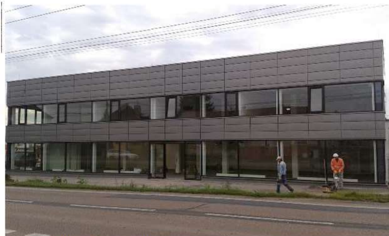
Opláštění autosalonu Hyundai Šrámek Plzeň
