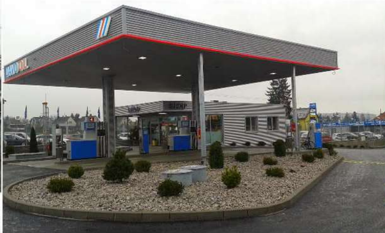
Zastřešení čerpací stanice pohoných hmot DAVO CAR Olbramovice - ocelová konstrukce 13000kg, včetně opláštění.
