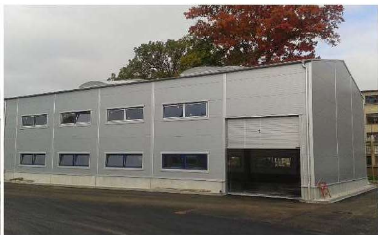
Opláštění výrobní haly Aweld Rokycany
